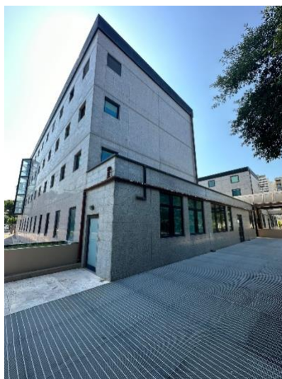
Vista esterna dell'ala Sud
