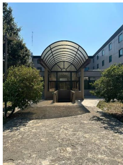
Ingresso pedonale dal parcheggio esterno
