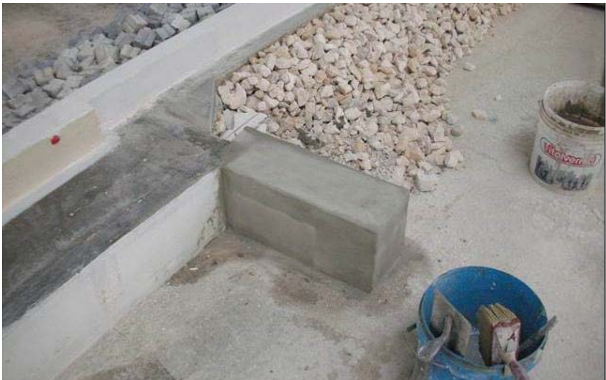
Fig. 6.3.1.15: nuovo setto a parete verticale in sostituzione dell'attuale a gettata in corrispondenza dell'imboccatura relativa alla configurazione attuale delle opere
