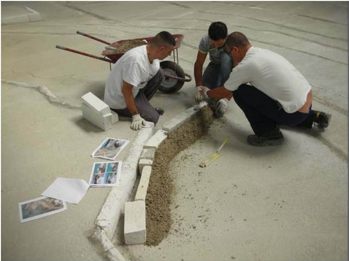
Fig. 2.20: Realizzazione del primo tratto della scogliera naturale.
