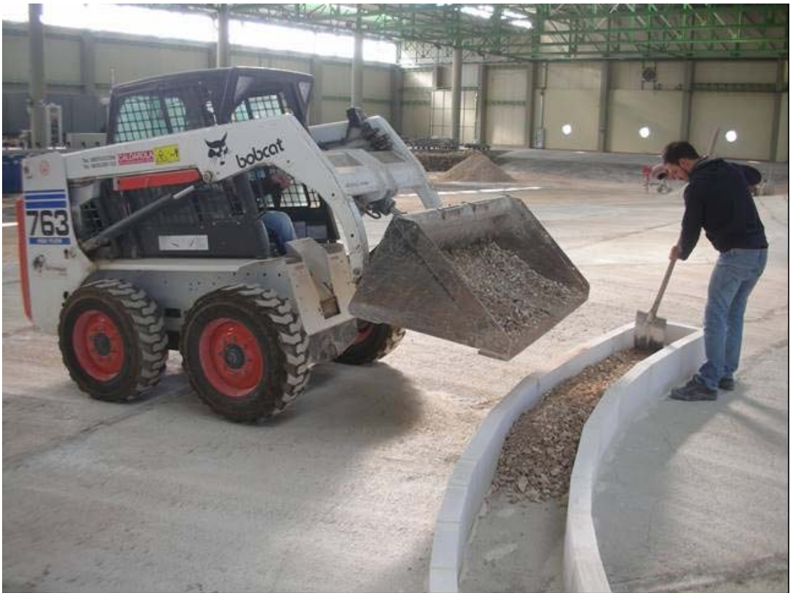
Fig. 2.28: Realizzazione della banchina del molo di sopraflutto. Riempimento con stabilizzato.
