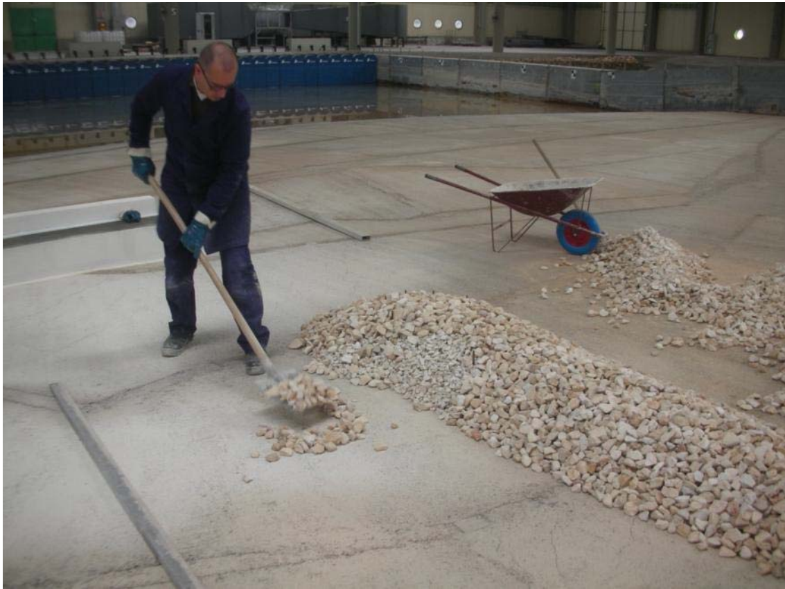
Fig. 2.40: fase di costruzione del modello: realizzazione del molo di sottoflutto.
