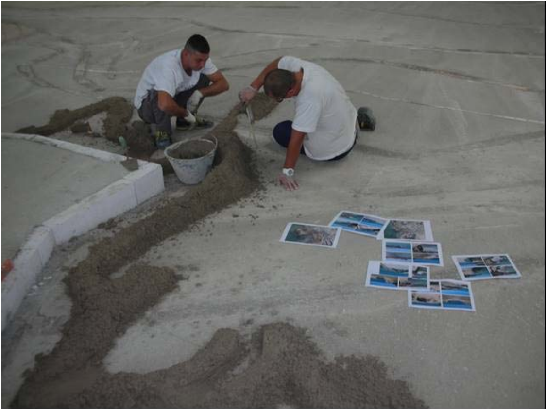
Fig. 2.22: Realizzazione della scogliera naturale. Una vista da sud
