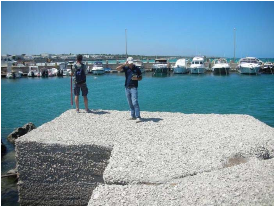
Fig. 2.5: particolare del rilievo GPS del molo di protezione del porticciolo interno.
