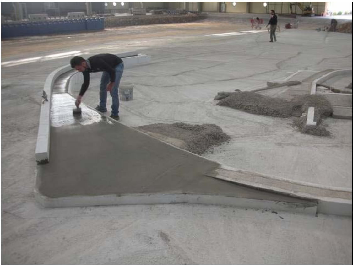
Fig. 2.32: Rifinitura della superficie superiore della banchina del molo di sopraflutto
