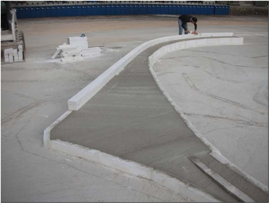
Fig. 2.31: Realizzazione del muro paraonde. Vista da terra
