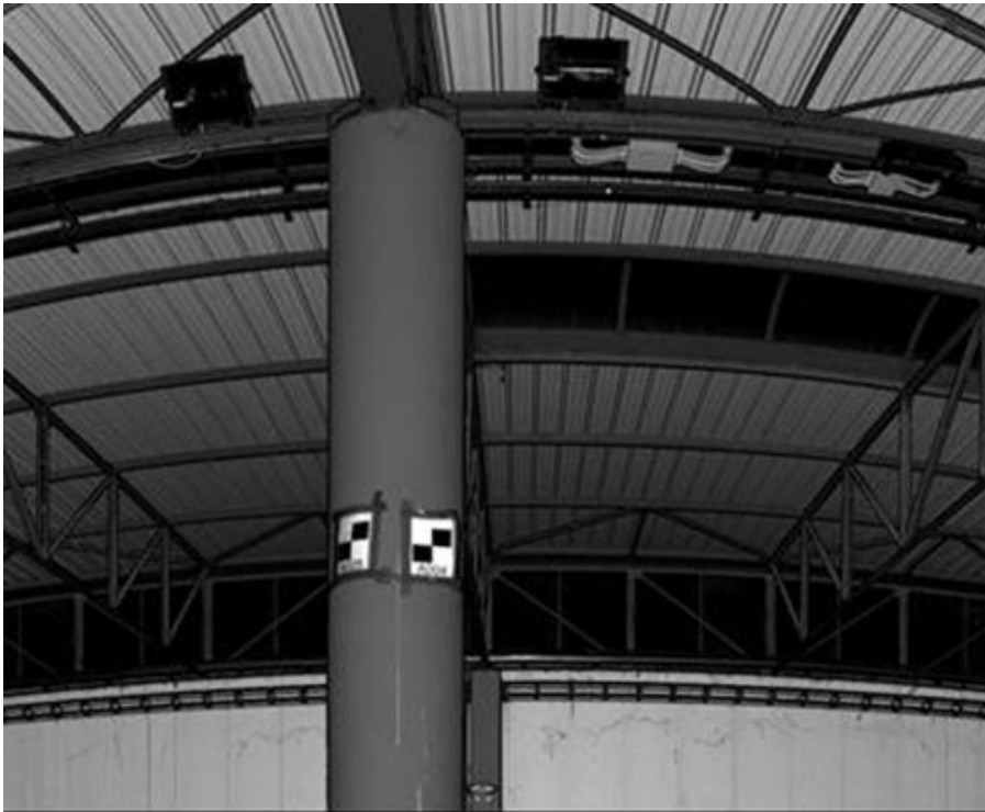
Fig. 6.1.2.1: un’immagine a riflettanza in cui si vedono alcuni target utilizzati
