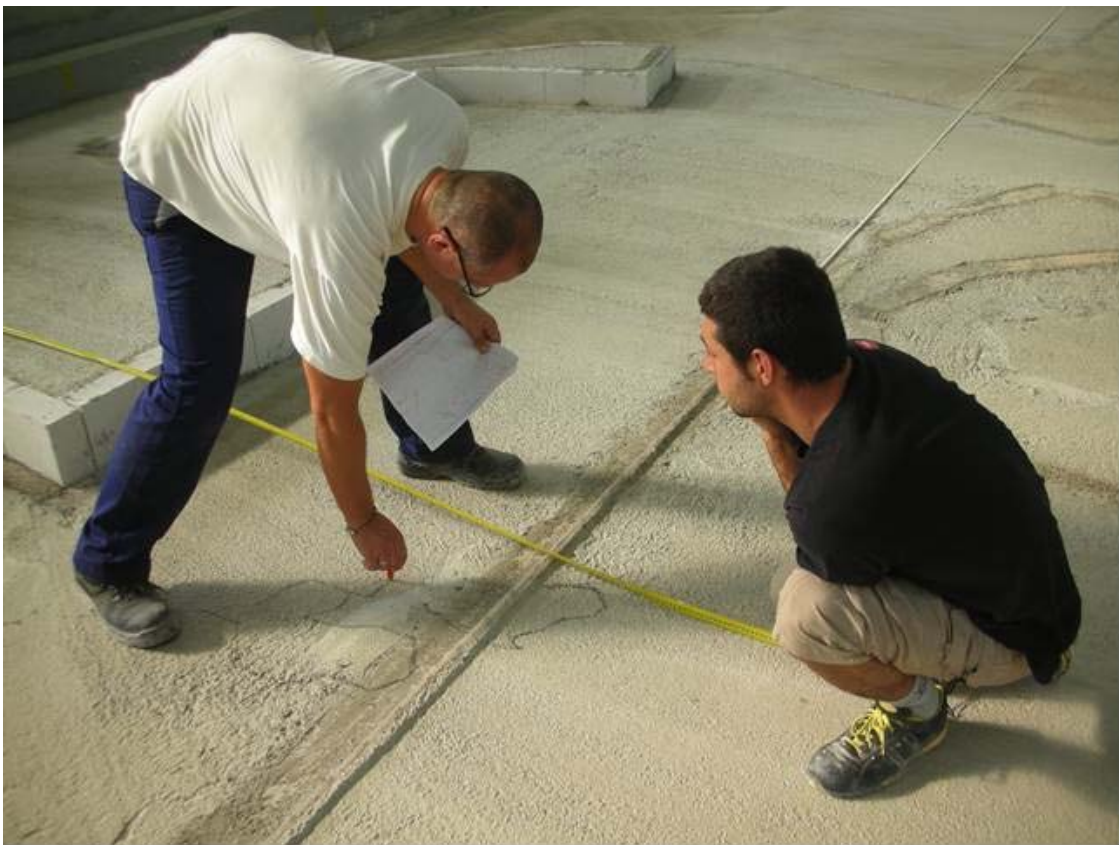
Fig. 2.16: Operazioni di tracciamento della costiera a terra.
