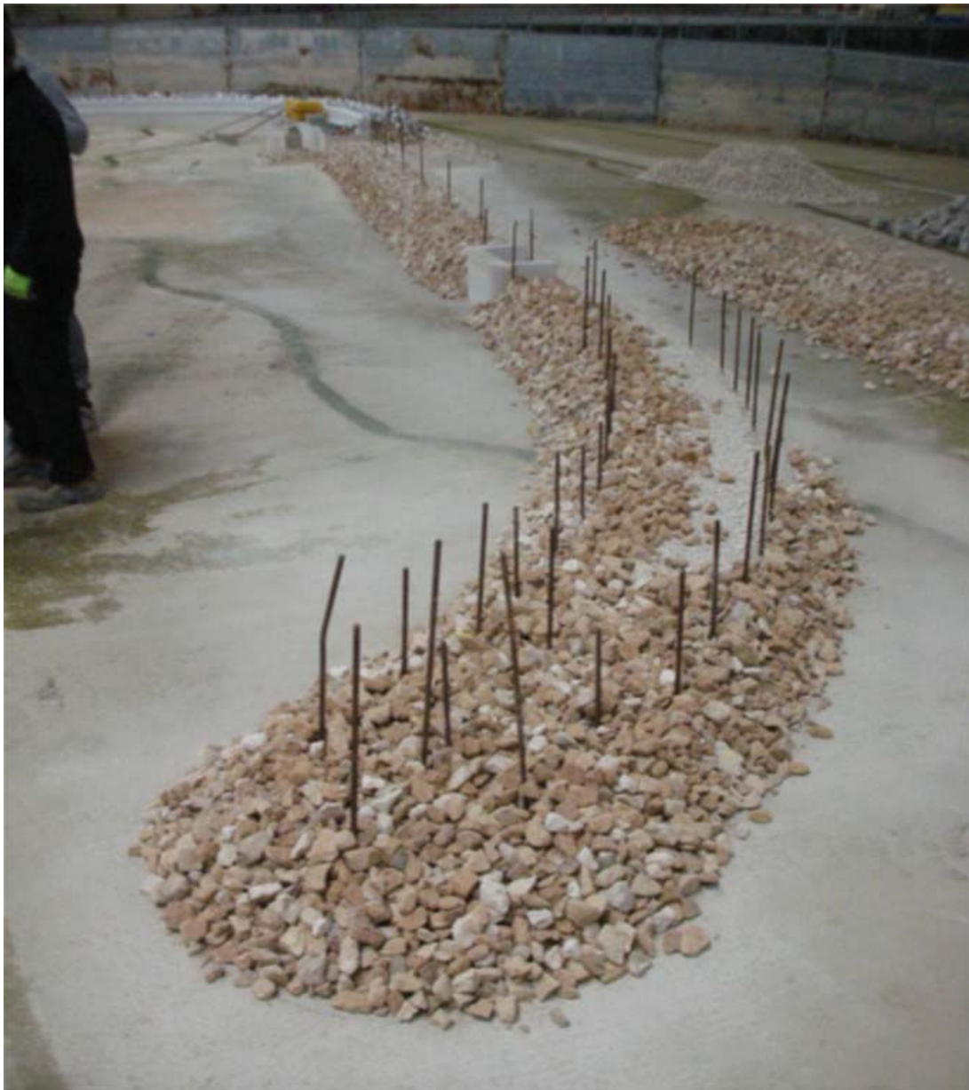
Fig. 6.3.1.4: lavori di costruzione dello strato filtro del nuovo molo di sopraflutto
