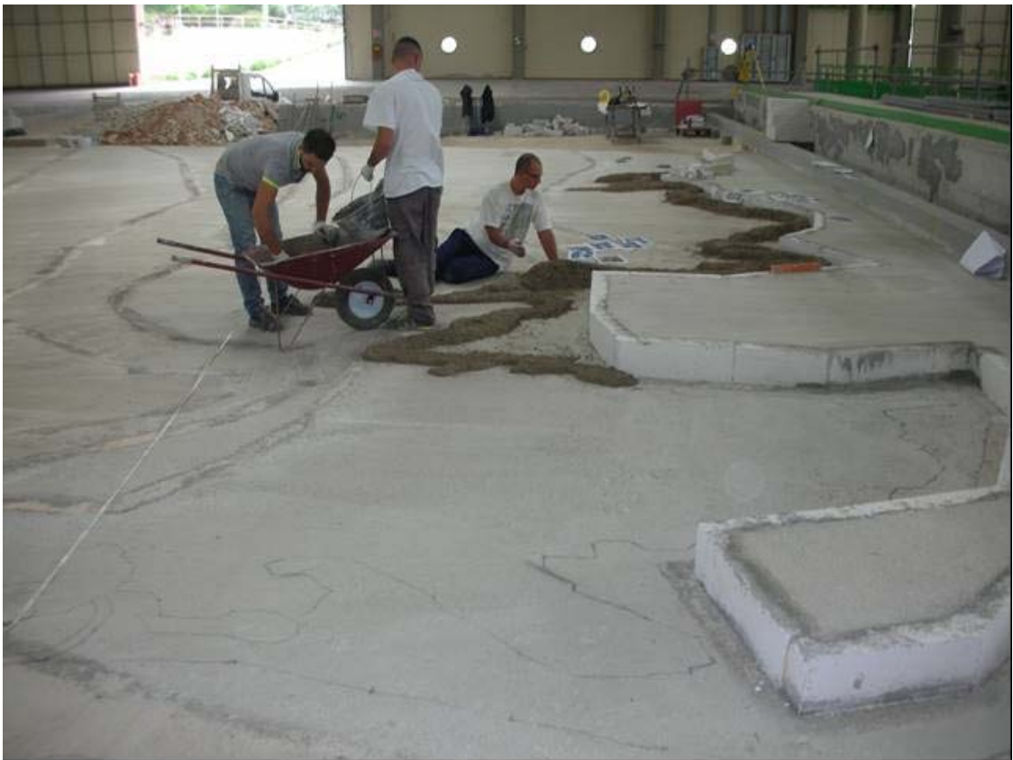
Fig. 2.21: Realizzazione della scogliera naturale. Una vista da nord
