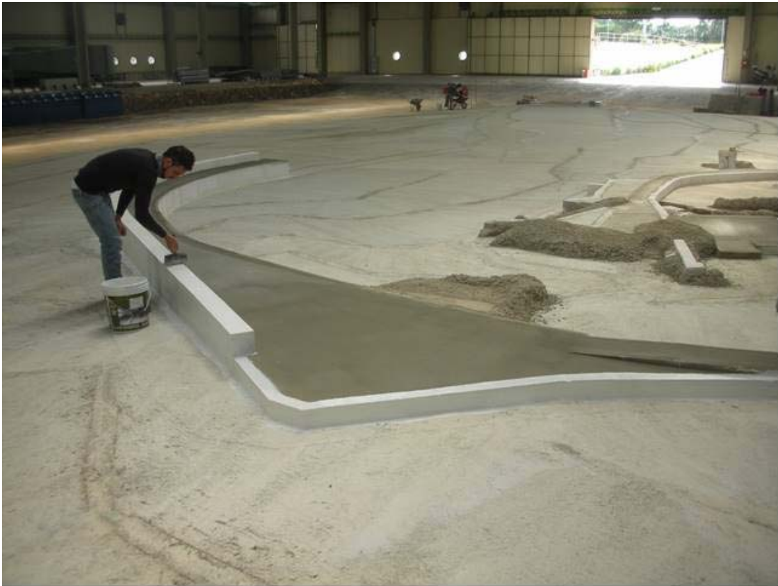
Fig. 2.33: Applicazione della guaina liquida lungo le superfici del muro paraonde
