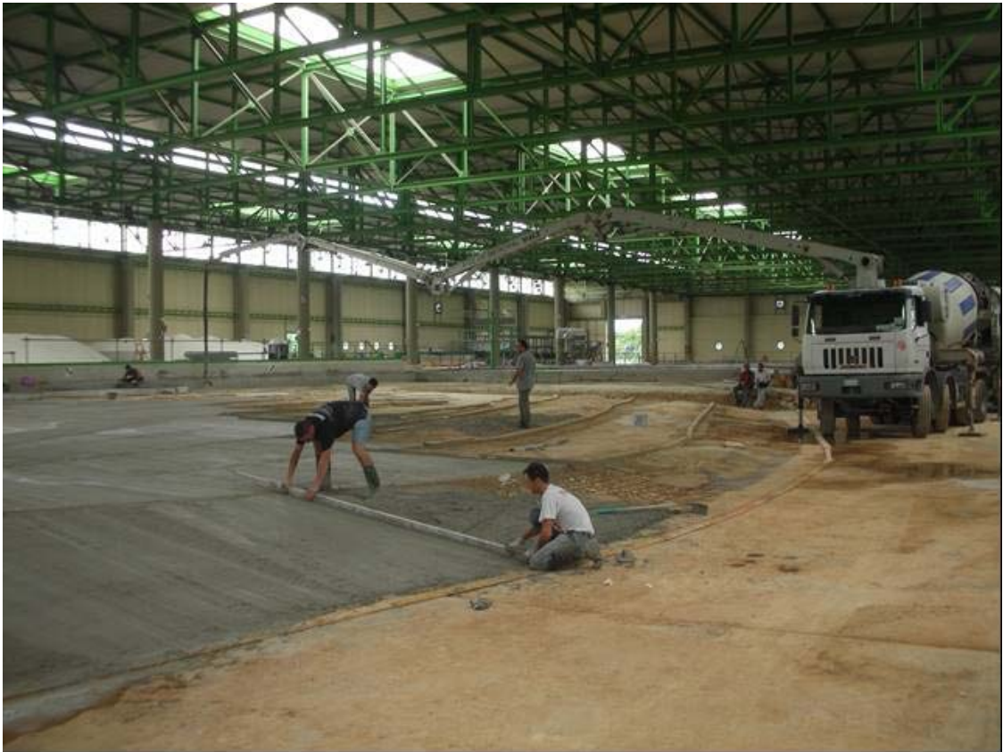
Fig. 2.14: Completamento della rampa di collegamento con il fondo vasca.
