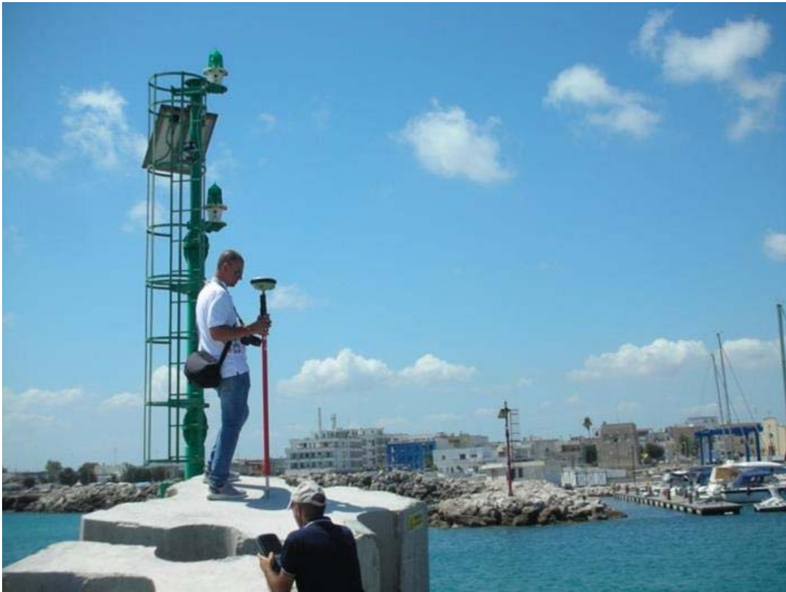
Fig. 2.4: particolare del rilievo GPS del molo di sopraflutto.
