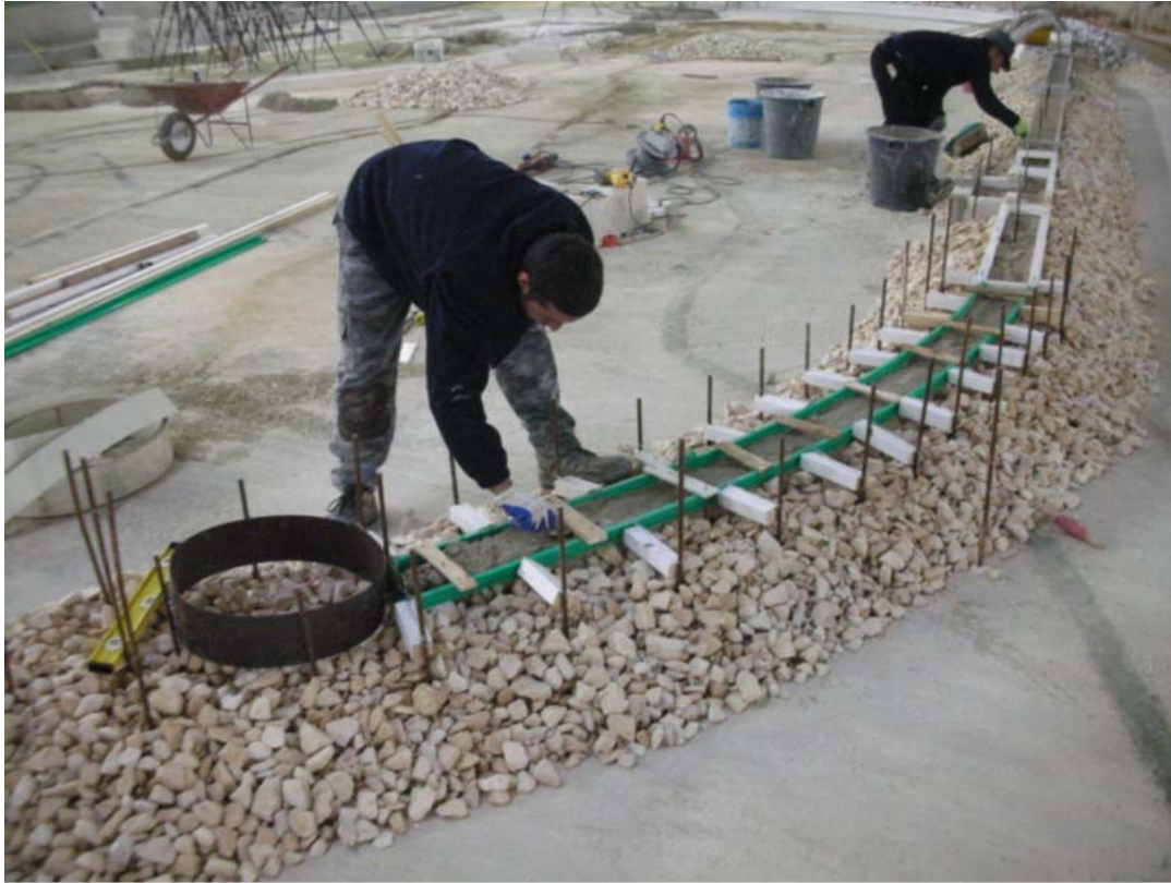
Fig. 6.3.1.5: lavori di costruzione del piano carrabile del nuovo molo di sopraflutto
