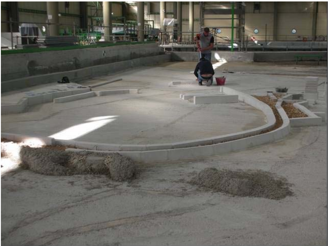
Fig. 2.25: Realizzazione della banchina di collegamento con lo scoglio Papuscia. Vista da mare
