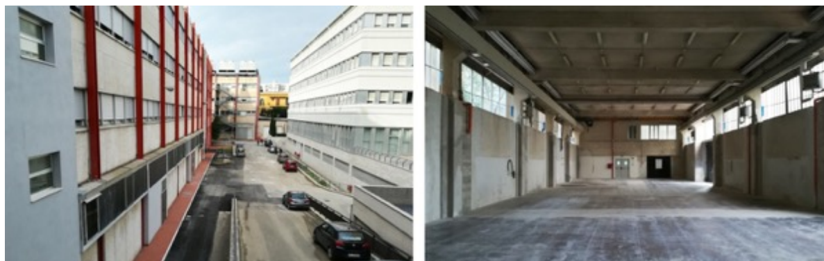
Fig. 3: Prospetto Est dell'edificio L01 e vista interna dell'ambiente OM1
