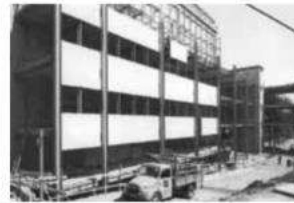
Cantiere della Facoltà di Ingegneria, aprile 1970.
