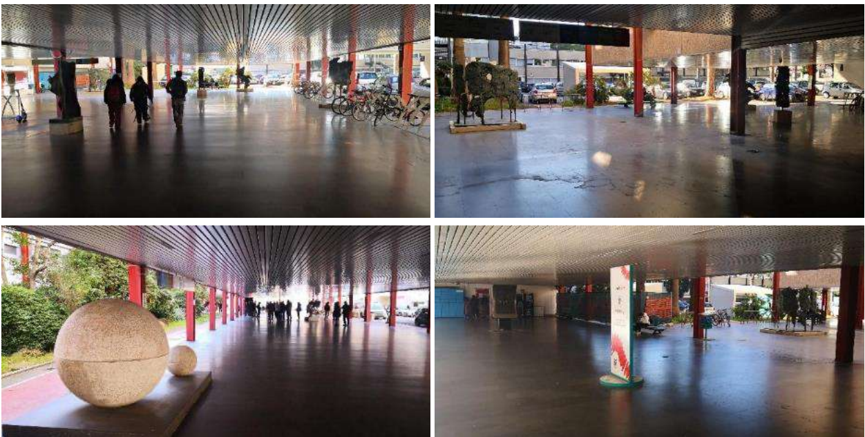
Foto attuale situazione Galleria delle Sculture, piano terra corpo a "Z" pilotis
