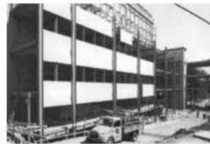
Cantiere della Facoltà di Ingegneria, aprile 1970.
